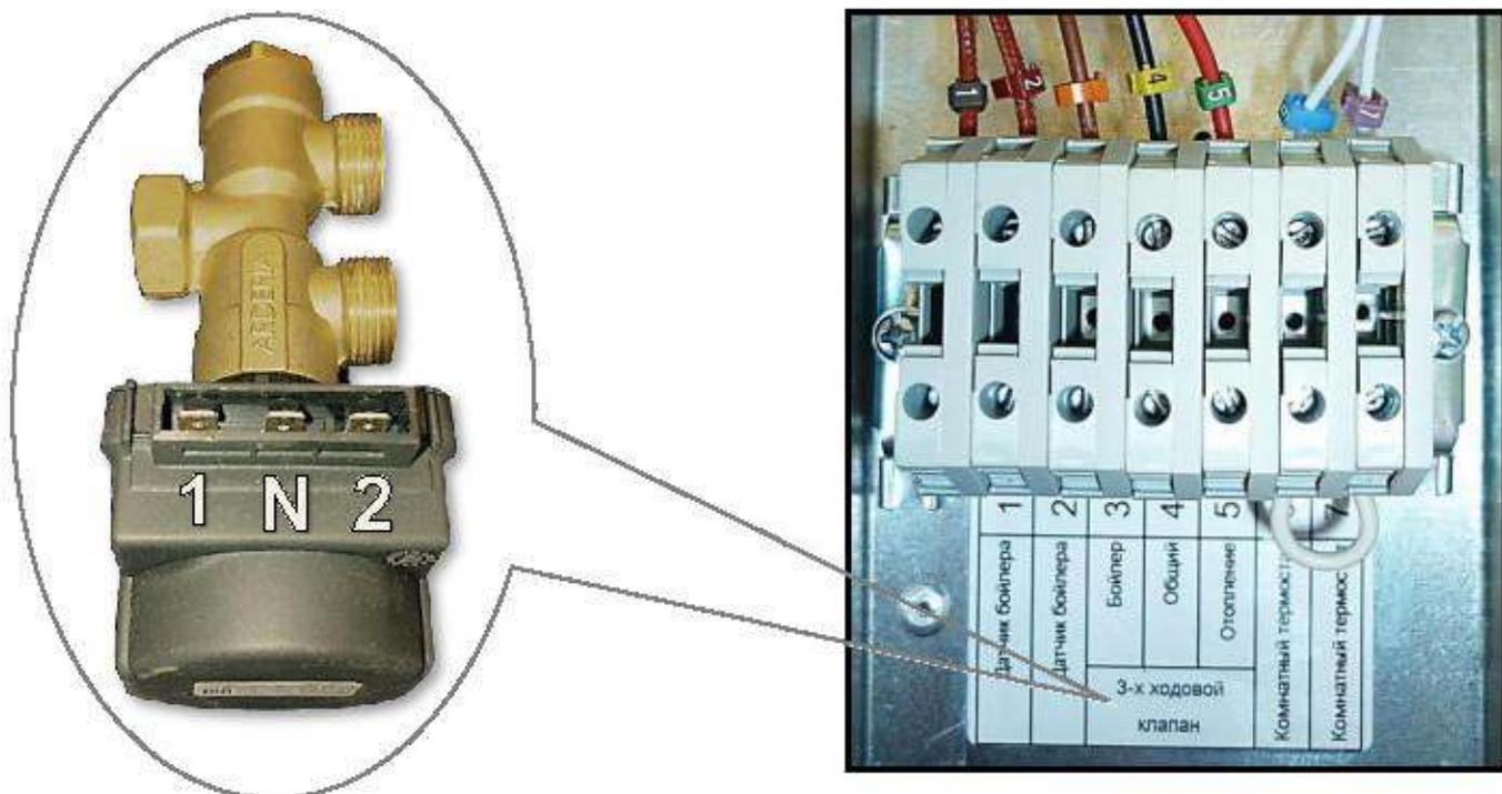
*Рис.23 Подключение трёхходового клапана «ARDERIA» к клеммной колодке.*
